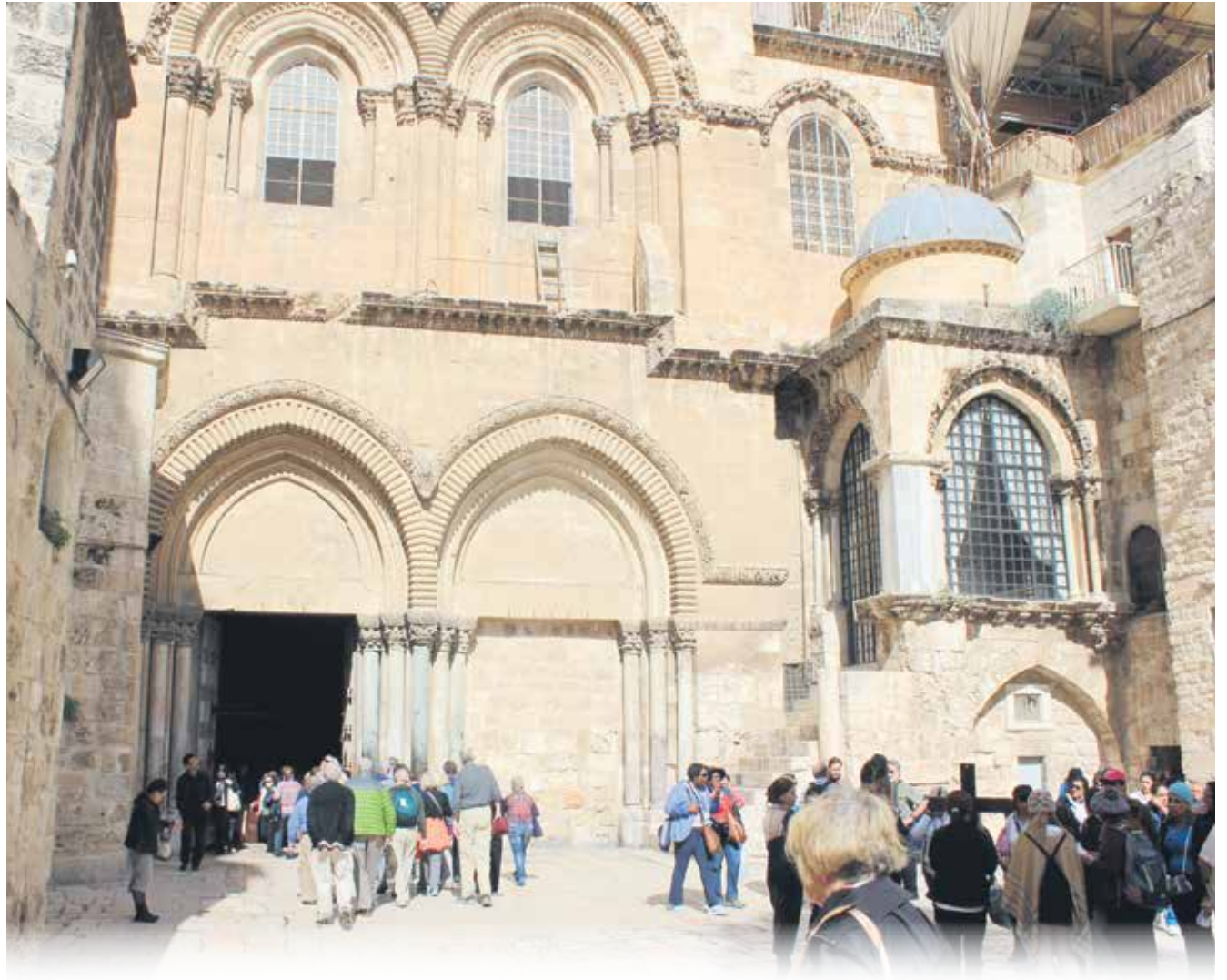
Pyhän Haudan kirkon sisäänkäynti, huomaa tikkaat ylhäällä ikkunan alla.
